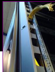
Airguide på 19" profil gir optimal luftgjennomstrømning. Airguiden sørger for at luft ikke går på feil side.
