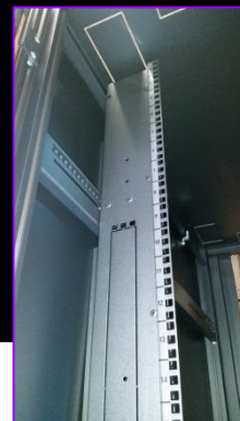
Airguide på 19" profil gir optimal luftgjennomstrømning. Airguiden sørger for at luft ikke går på feil side.
